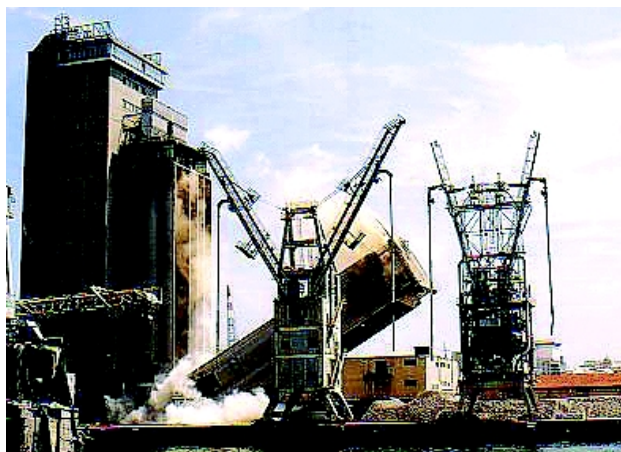
Ponte Parodi (GE): terz'ultimo concio da 4.000 tonnellate
