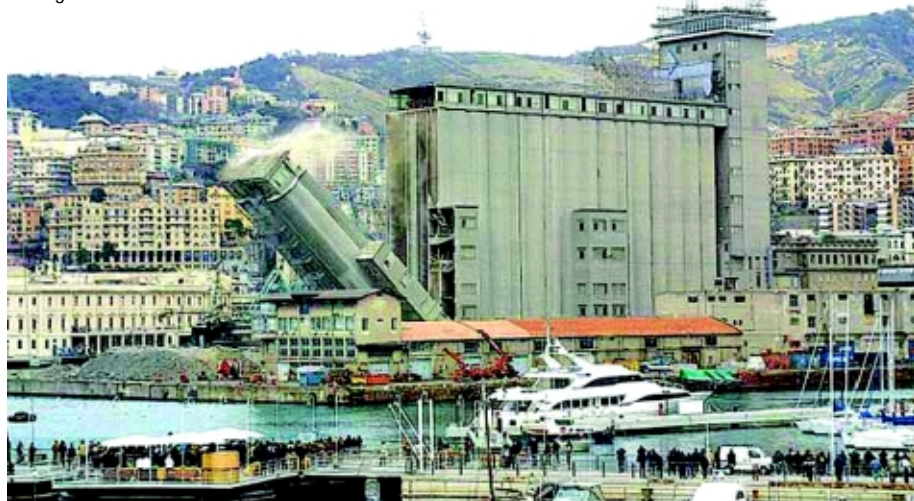
Silos granari di Ponte Parodi a Genova: inizio lavori
