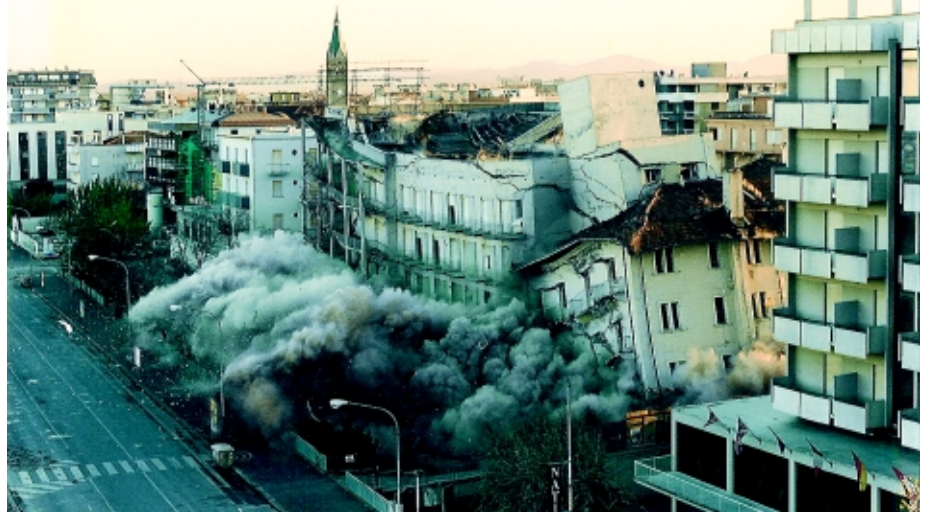
Demolizione di albergo sul lungomare di Rimini
