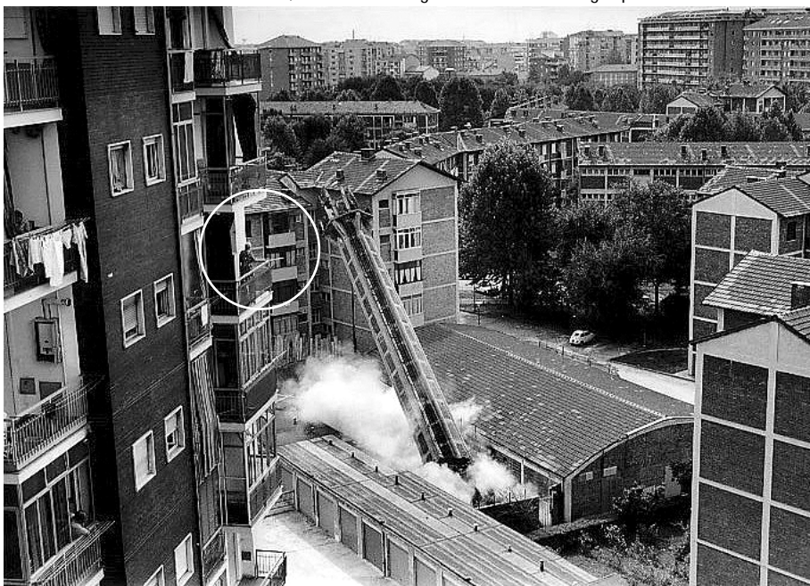
Abbattimento di ciminiera in strettoia, nessun danno agli edifici limitrofi né agli spettatori
