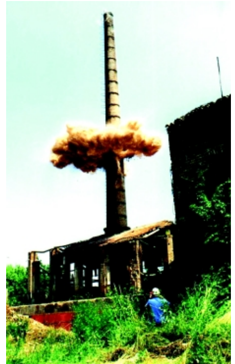
"Spuntatura" di una vecchia ciminiera in mattoni
